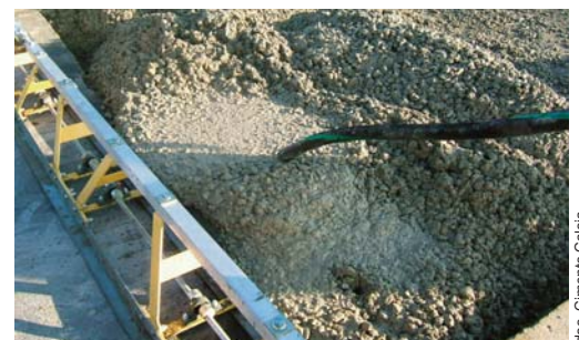
Pervibration du béton à l'aiguille vibrante.
