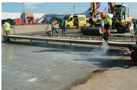
Application du produit de cure dès la mise en œuvre.
