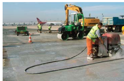
Sciage du béton quelques heures après la mise en place.
