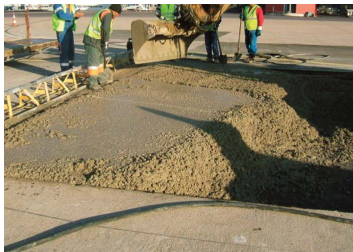
Égalisation grossière du béton avant passage de la règle.
