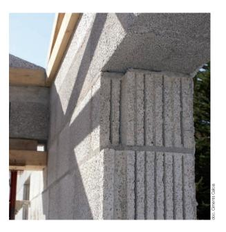
Conforme à la norme NF EN 998-2, Batiponce (conditionné en sacs de 20 kg) se compose d'un liant hydraulique (chaux NHL, ciment Portland), de charges minérales légères et d'adjuvants. Batiponce peut être stocké jusqu'à 6 mois à partir de la date de fabrication indiquée sur le sac, en respectant les conditions de stockage préconisées.
