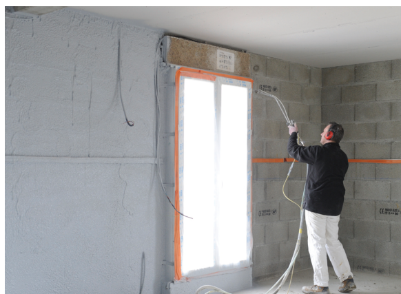
Application à la machine à projeter du weber.mur int'air sur les murs intérieurs et les jonctions, pour une étanchéité renforcée !
