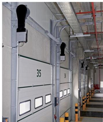
● Disponible depuis mars 2013, la **motorisation WA 300** avec faible consommation d'énergie voit l'extension de son domaine d'utilisation avec des dimensions allant désormais jusqu'à 6.000 x 4.500 mm. Elle peut, en option, recevoir la commande 300 U avec sectionneur multipolaire intégré. Hörmann propose également une démultiplication spéciale pour une vitesse de déplacement plus rapide des portes jusqu'à 3.500 x 3.500 mm (ferrure H ou V).
