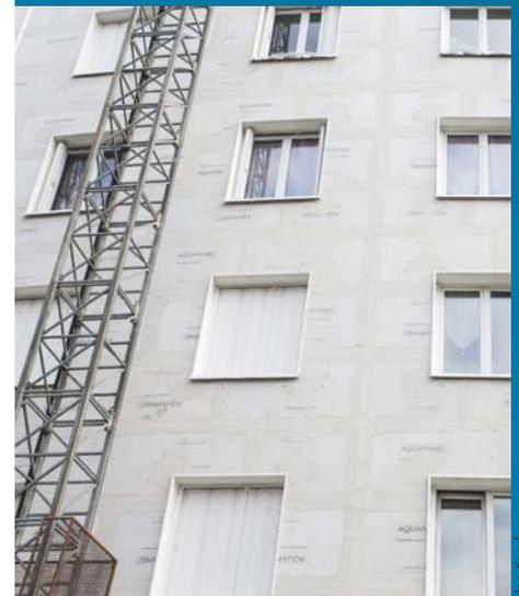
Le bardage en plaque de ciment Aquapanel® Outdoor de Knauf, posé sur l'ancien ITE et sur un isolant supplémentaire, prêt à accueillir les plaques d'émaux.
