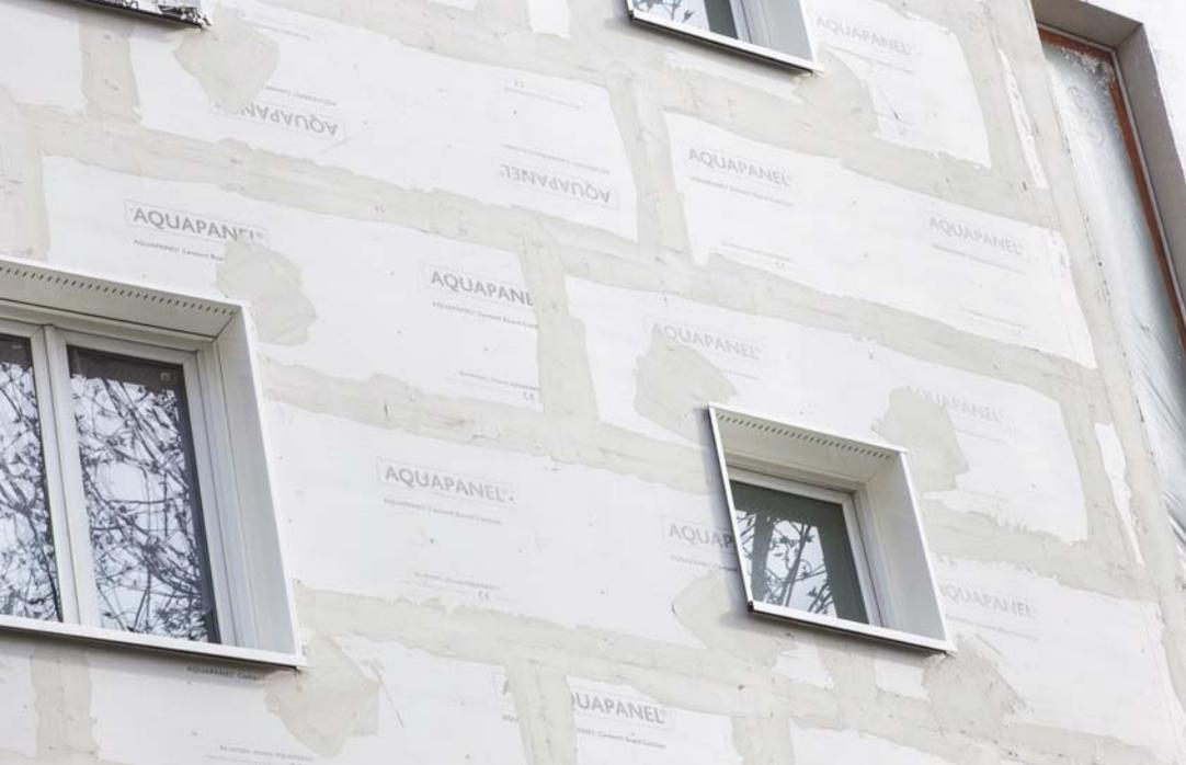
Plaque de ciment de Portland armée sur les deux faces, Aquapanel® Outdoor de Knauf s'avère la solution bardage extérieur qui répond à toutes les configurations et exigences des bâtiments.
