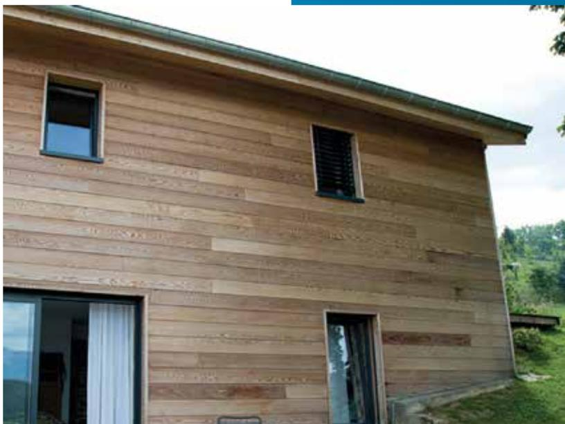
A l'instar de Knauf Thane Façade, Knauf Thane Façade MI est compatible avec une large gamme de finitions et disponible en 6 épaisseurs.
