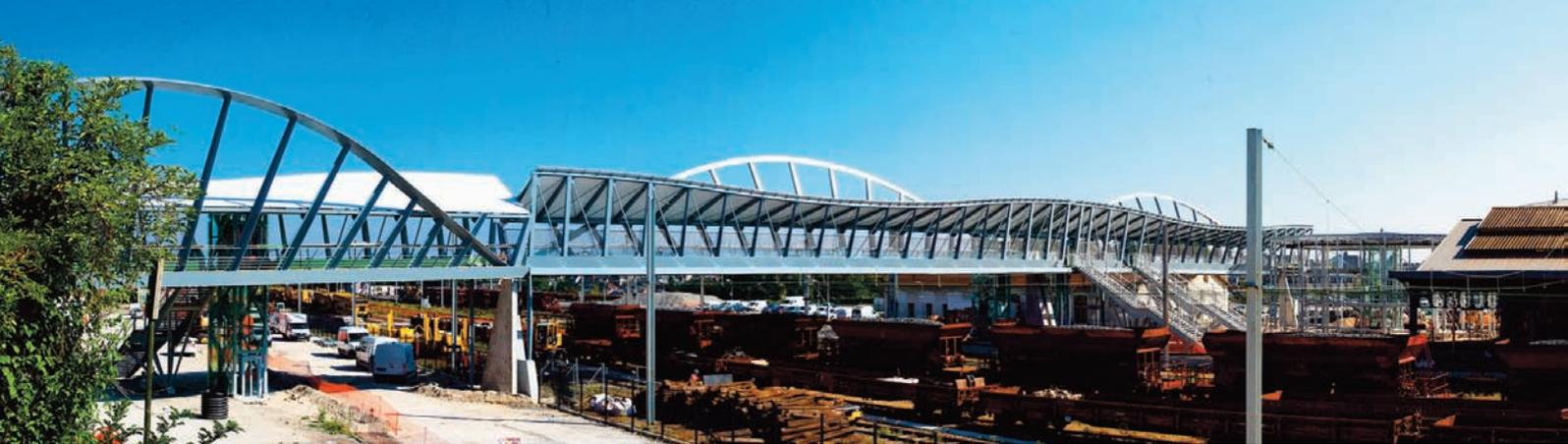
Pour l'Agence B+M Architecture, en équipe avec l'ingénierie Coredia, l'acier s'est imposé pour la structure de la passerelle de Blois du fait de sa légèreté et de sa mise en œuvre aisée, par levage de tronçons de 130 tonnes. L'ensemble aura constitué environ 400 tonnes d'acier pour 13.000 heures de travail en atelier.
