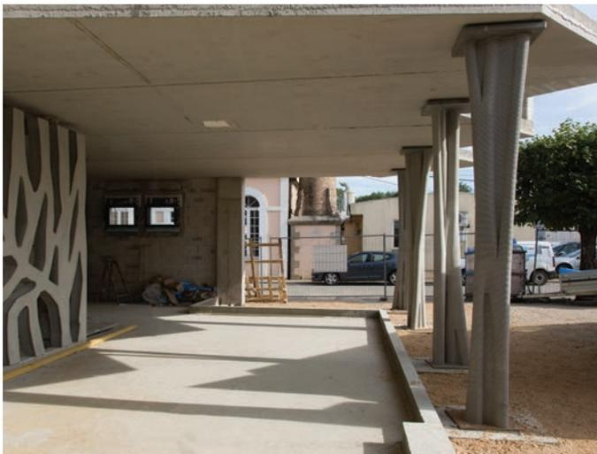
Les poteaux réalisés à l'aide de l'impression 3D par Lafarge et XtreeE soutiennent le plancher de l'étage.
