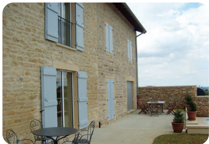
Saint-Amour-Bellevue (71) - restauration d'une maison à pierres vues avec weber liant chaux coloré .
