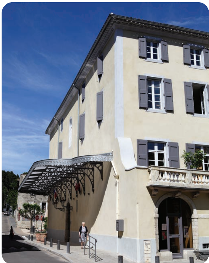
La rénovation de la façade de la Mairie de Saint-Jean-du-Gard (30) a conjugué la mise en œuvre de l'enduit weberbase facim fin à la réalisation d'un badigeon chaux et silice.
