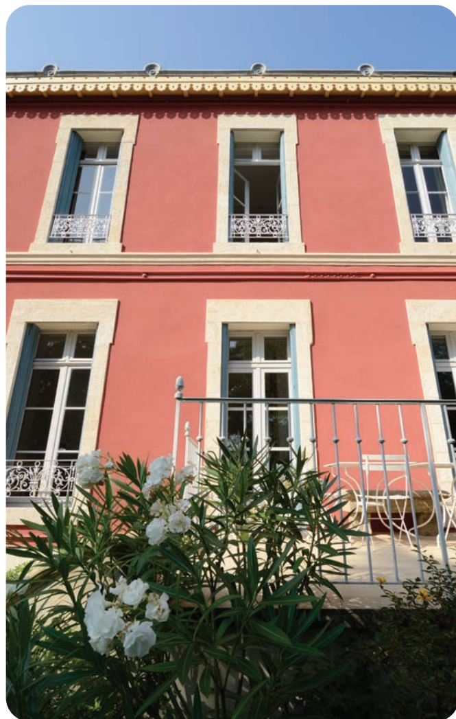
Le mortier à la chaux webermep plus et l'enduit de finition weberprodexor K+S ont été mis en œuvre pour la rénovation de la façade colorée de cette demeure située à La Rouvière (30).
