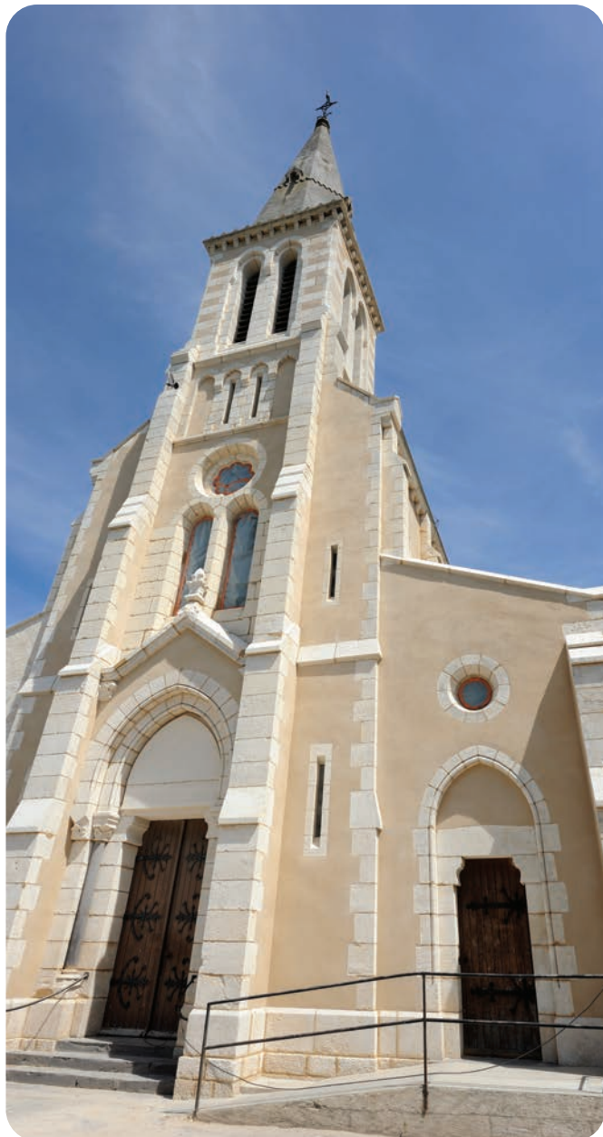
Église Saint-Nicolas de Chantelle (03), rénovée en façade avec la solution parement grain fin projeté de la gamme Les Enduits Georges Weber et le sous-enduit minéral weberdress clair .
