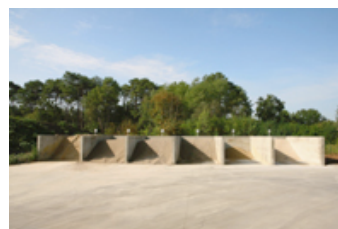
Le local adjuvant et les 7 cases à granulats de la centrale de Langon
