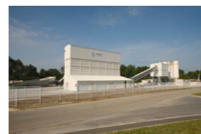
Le Bardage des installations
