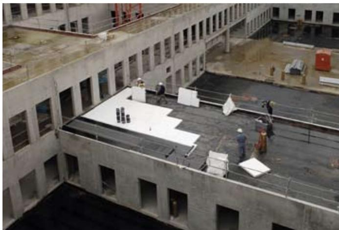
Soudure de la membrane d'étanchéité (Soprema) sur l'isolant Knauf Therm, posé sur les dalles béton des patios et toiture-terrasse du Centre Hospitalier de Douai (59).
