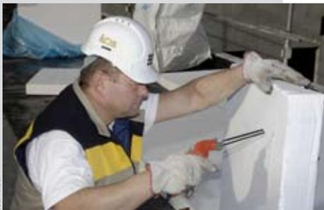
Facile à utiliser, le fil chaud assure des coupes nettes du Knauf Therm, parfaitement respectueuses de la gestion d'un chantier HQE®.
