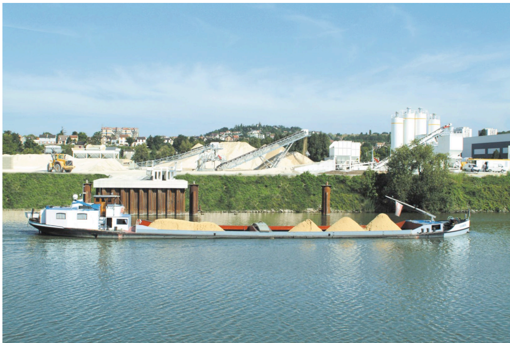
L'acheminement des granulats par voie fluviale
