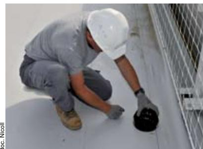
Facile à mettre en œuvre, discret et efficace, le système par dépression Akasison optimise l'évacuation des eaux pluviales.
