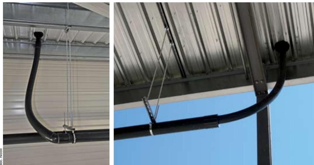
Gros plans sur les flexibles de raccords au grand rayon de courbure qui grâce à leur ingénieuse conception ne nécessitent pas de manchon.
