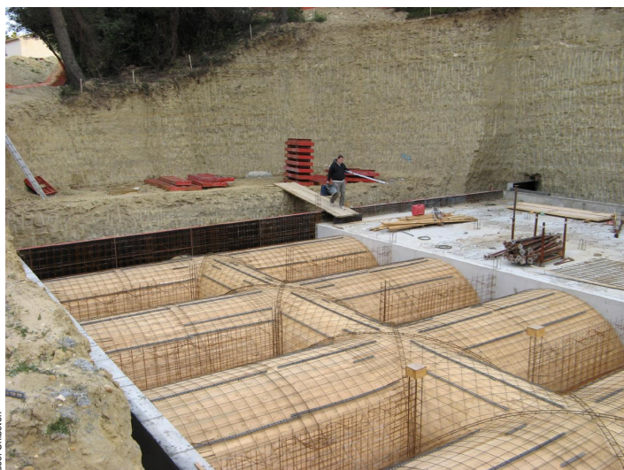
Coffrage vu de l'extérieur
