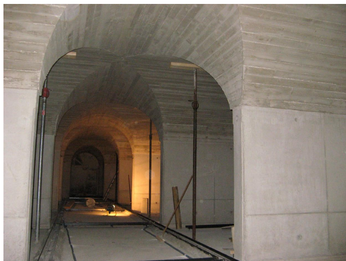
Chantier en cours
