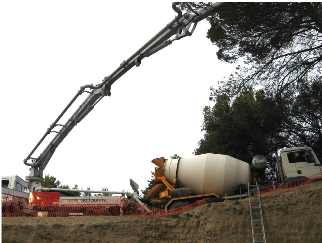
Mise en œuvre à la pompe
