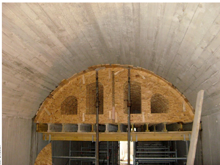
Coffrage vu de l'intérieur
