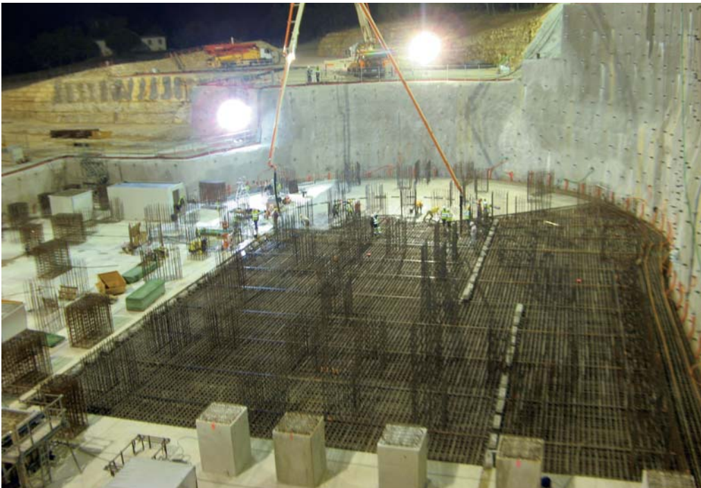
◀ Coulage du radier inférieur de nuit.
