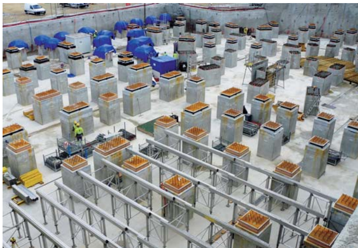
▲ RJH, une des premières unités nucléaires construite sur appuis sismiques.
