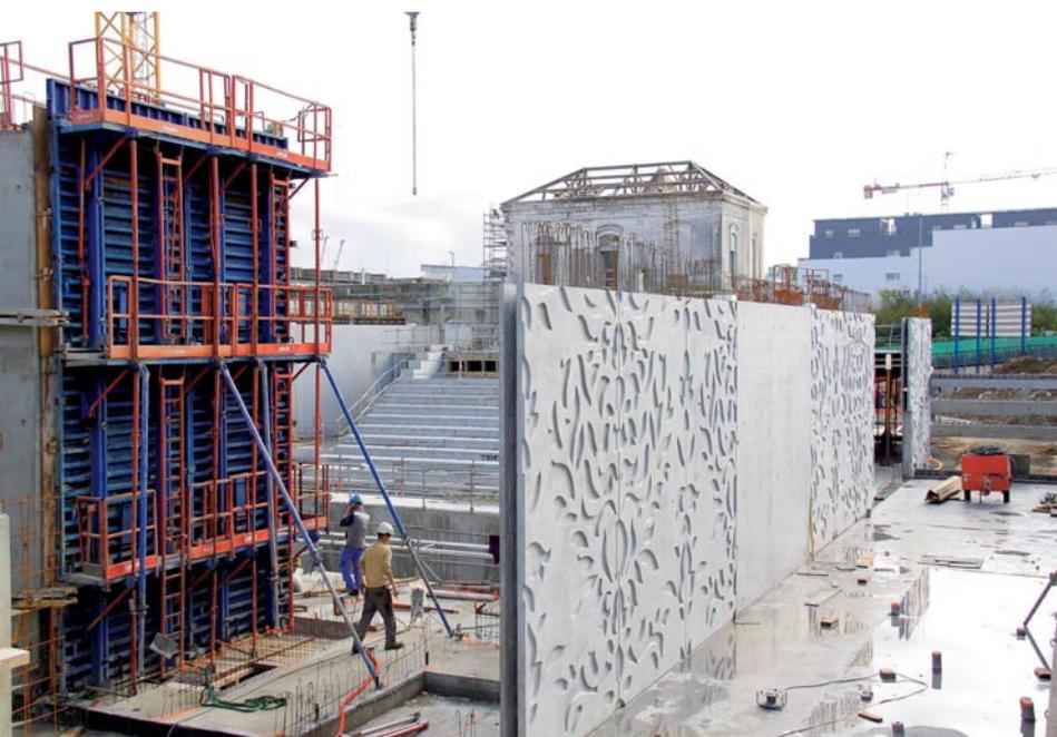
▲ La construction du Théâtre de Saint-Nazaire fait appel à la préfabrication d'éléments réalisés et mis en œuvre par l'entreprise Savoie Frères à partir du CEM II 42.5R CE PM-CP2 NF de Ciments Calcia. Technique et esthétique se retrouvent ici pour un édifice original et novateur...
