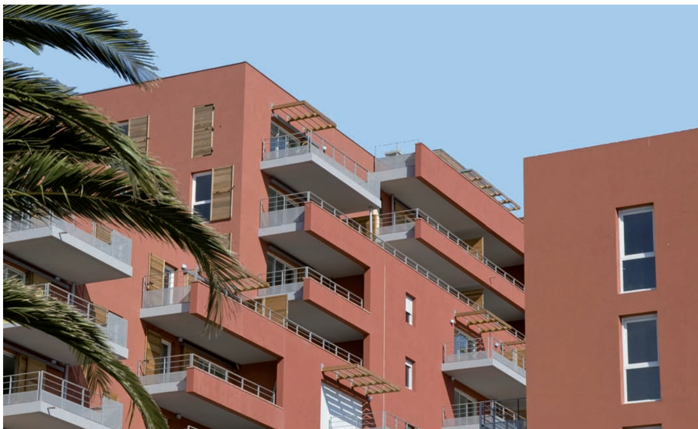
Ensemble de bâtiments collectifs à Sète (34).
