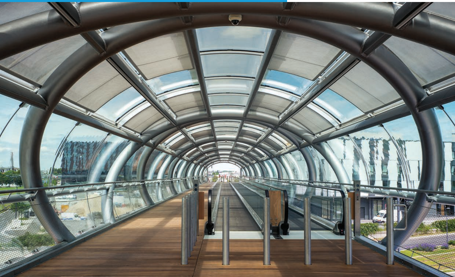
Passerelle piétonne entre le quartier d'affaires Cœur d'Orly et l'aéroport Orly Sud.
