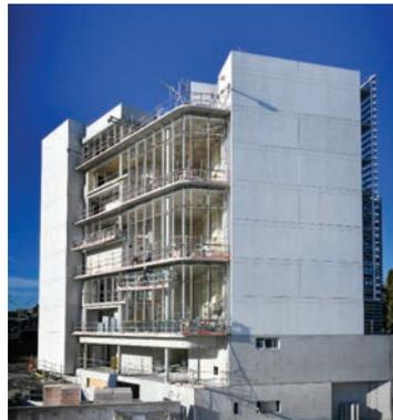
i.active ULTRA de Ciments Calcia s'adapte parfaitement à la réalisation de panneaux architectoniques préfabriqués comme ceux mis en œuvre sur la façade de la Maison de la Corée.
