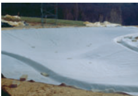
Constituant une protection très efficace contre la perforation, grâce à leur extrême résistance au poinçonnement, les géotextiles bidim® s'installent entre le béton et les couches d'étanchéité pour pérenniser les bassins et piscines.
