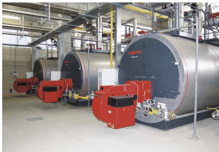
La Vitomax 200-LW type M62A est une chaudière fioul/gaz à eau chaude basse pression pour des températures de départ jusqu'à 120 °C et une pression de service de 6 à 16 bars. Elle est particulièrement recommandée pour une utilisation dans les centrales de chauffage, les établissements industriels et communaux (de 2,3 à 6 MW), en neuf comme en rénovation.
