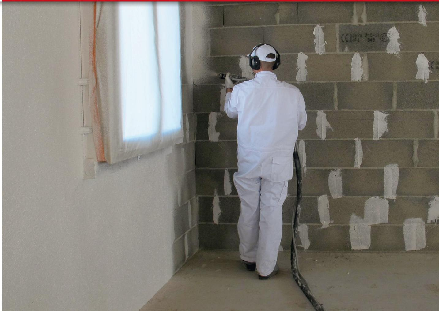
Performant et efficace, Bagar Air de Beissier, l'enduit à projeter nouvelle génération, en phase aqueuse, garantit l'étanchéité à l'air des murs périphériques et ponts thermiques, pour un bâti sain.
