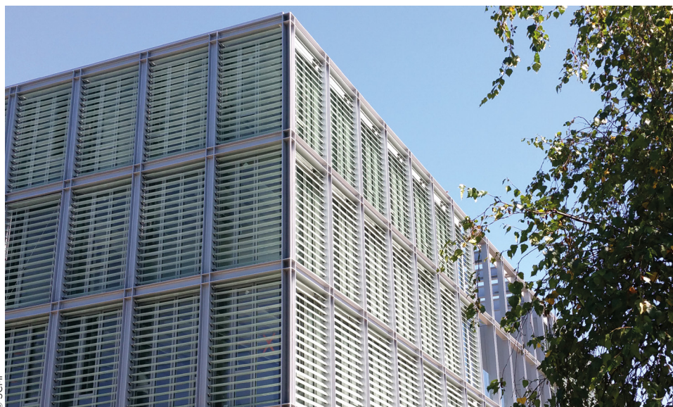
Autre brillante démonstration de la construction métallique, le nouveau bâtiment qu'occupera l'Ecole Nationale de la Statistique et de l'Administration Publique (ENSAE) à Saclay.
