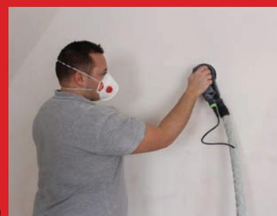
1/ Préparation du support avec ponçage de la pièce. 2/ Époussetage. 3/ Masquage. 4/ Application de l'impression. 5/6/ Préparation du Prestonett F-Acénis. 7/8/9/ Enduisage du plafond et des murs. 10/ Ponçage.
