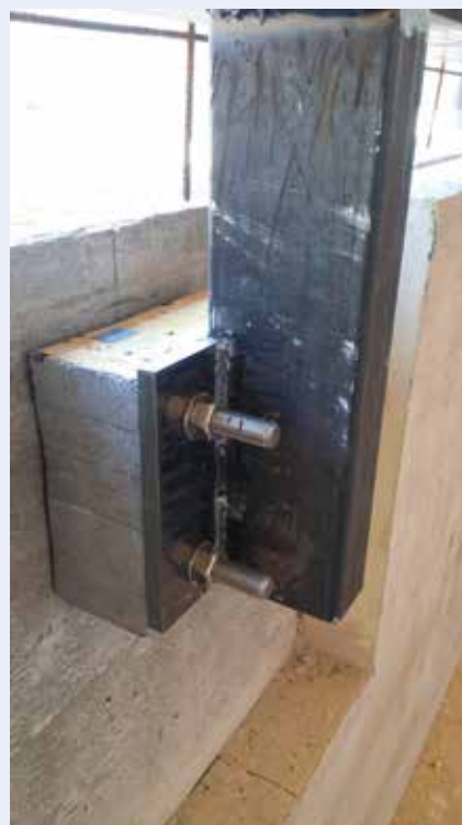
Les liaisons maçonnerie-structure métallique ont été traitées avec les rupteurs Schöck Isokorb® type KST.
