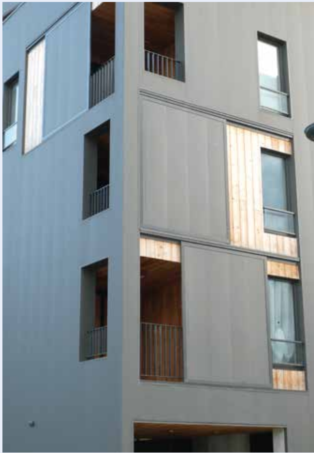
Les liaisons mur-dalle loggia ont été traitées avec les rupteurs Schöck Rutherma® type Q.
