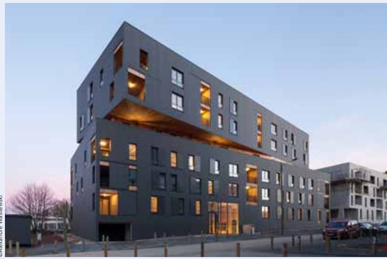
Le Mouvement Perpétuel est, à ce jour, le plus important bâtiment collectif passif du Grand Ouest.
