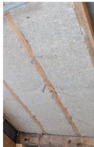
Pose en rampant entre chevrons
