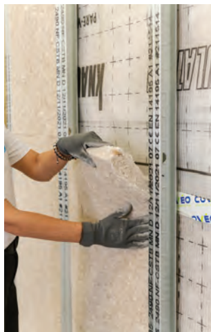
Insertion entre montants
