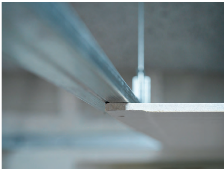
Knauf Lightboard Horizon 4 sera vissée perpendiculairement aux ossatures KNAUF F47
