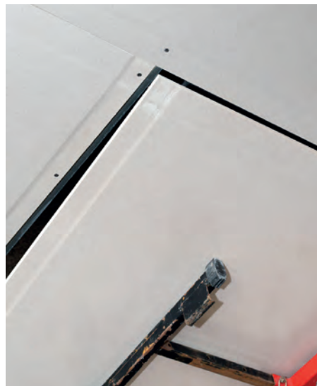
Possibilité de visser les plaques Knauf Lightboard Horizon 4 à joints alignés ou à joints décalés
