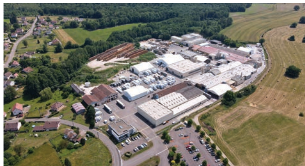
Vue aérienne du site Knauf Fibre de La Côte (70)
