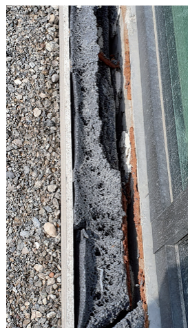
Isolant dégradé par le rayonnement solaire
