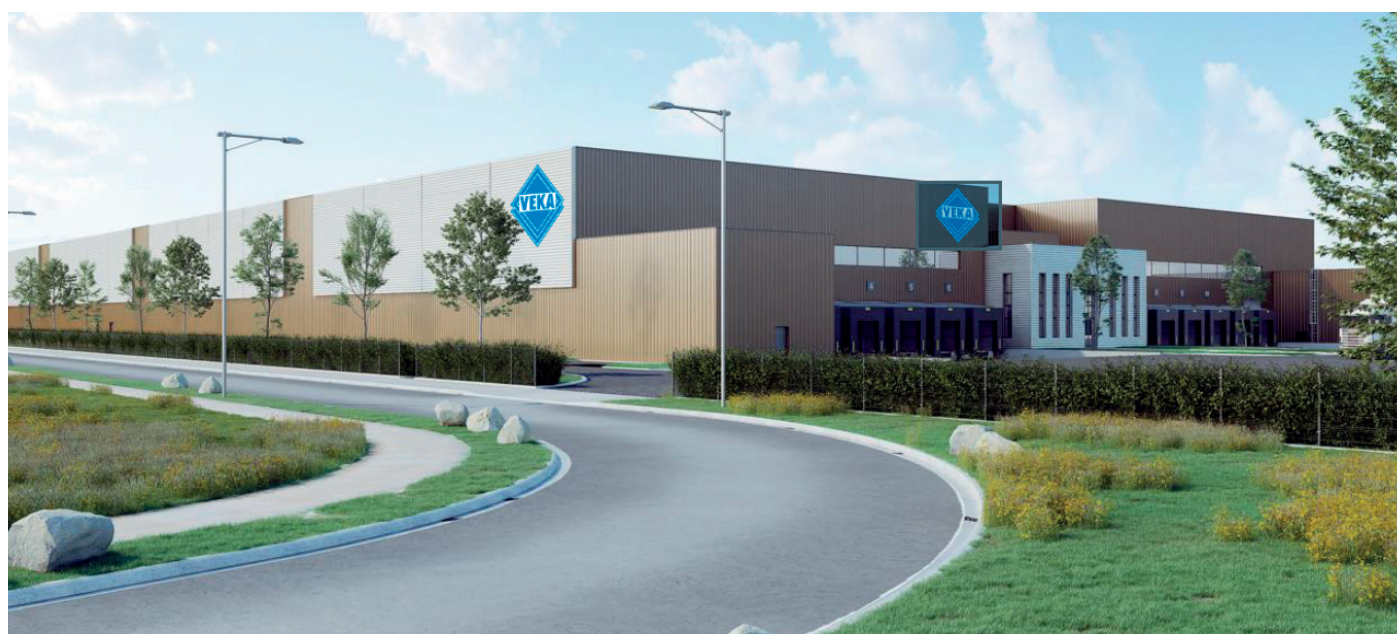
Nouveau centre logistique VEKA situé en Saône-et-Loire et opérationnel début 2025
