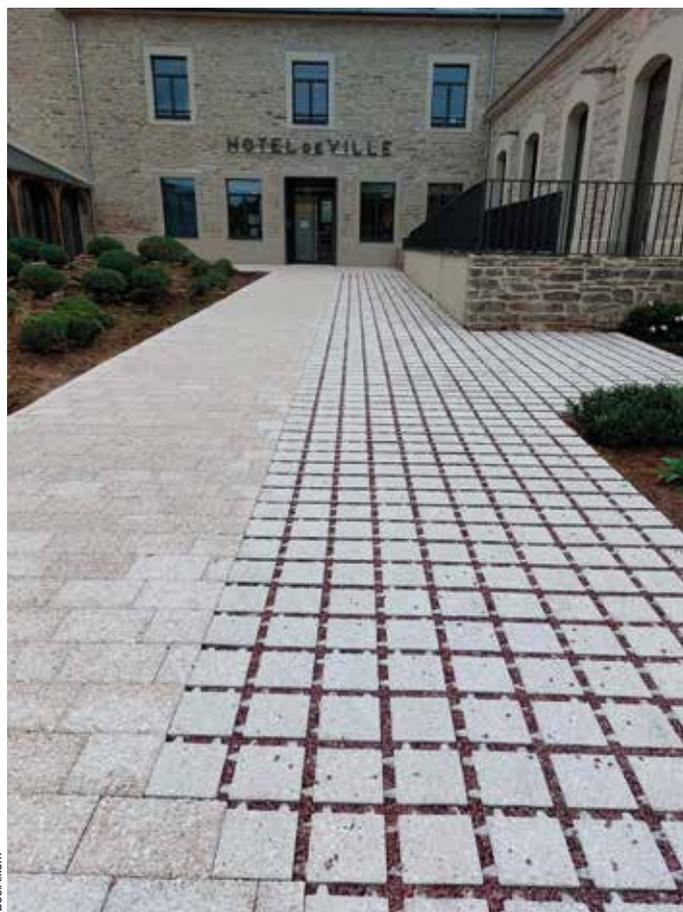
Les pavés Coquillage d'Alkern, au coefficient de perméabilité élevé, intègrent des coquilles Saint-Jacques (30 kg/m<sup>2</sup>) en remplacement des granulats naturels non renouvelables, ici la nouvelle allée de l'Hôtel de Ville de Guichen (35).
