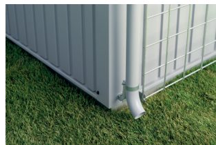
2. Zoom sur la descente d'eau pluviale.
