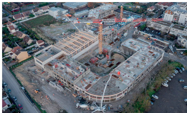
Doc. OFFICINA & GRD Architectes/Guillaume Guérin
