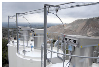
Les filtres de dépoussiérage équipant les silos
