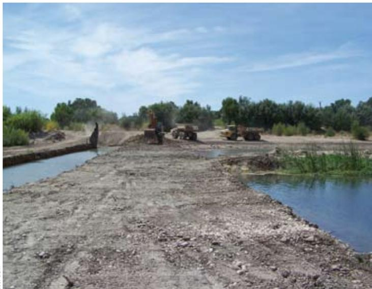
Dans le cadre des travaux de réaménagement coordonné, réalisation d'un bassin de retenue des eaux du Gardon en cas d'inondations avec une capacité de stockage de 1,5 million de mètres cube. Notons que ce réaménagement se destine également à des loisirs de pêche et s'avère un lieu propice à la biodiversité puisque les castors, population représentative des berges du Gardon, s'y plaisent autant que de l'autre côté de la rive...
