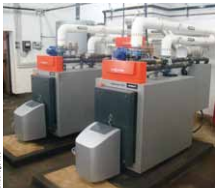
Chaudières fioul à condensation Vitoradial de 129 kW chacune couplée pour l'ECS à 20 m 2 de capteurs solaires, à un échangeur à condensation Vitotrans 222 et à un ballon d'ECS (Ateliers SNCF à Bobigny).
