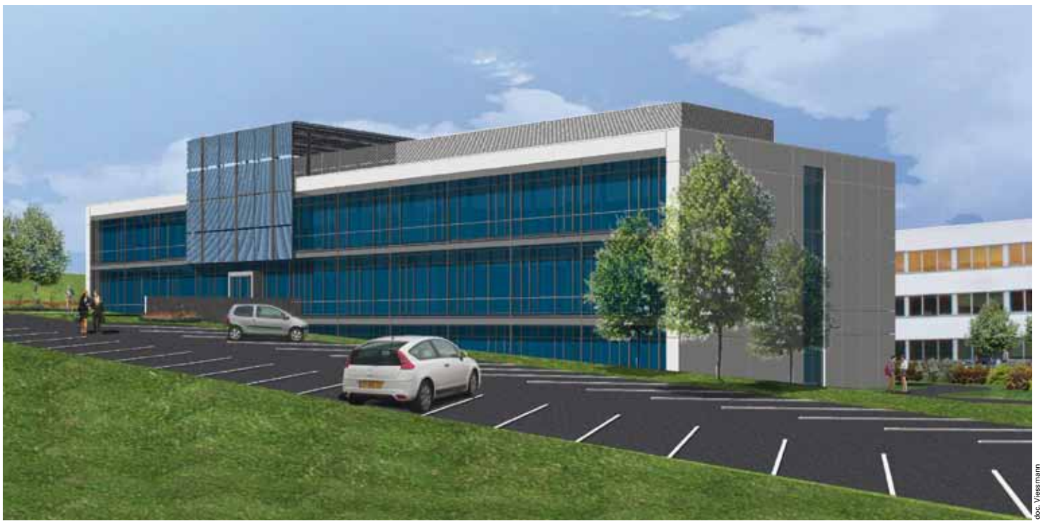
Le nouveau siège de Viessmann France sera opérationnel fin 2012.
