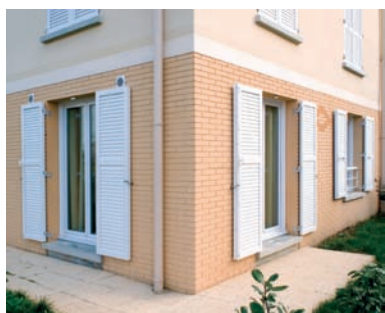
Matriçage d'une façade à l'aide du weber.terranova print .
