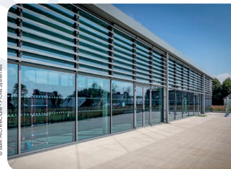
Brise-soleil lames d'avion. Pose horizontale sur cadre. Couleur Alu naturel - Profils Color®
