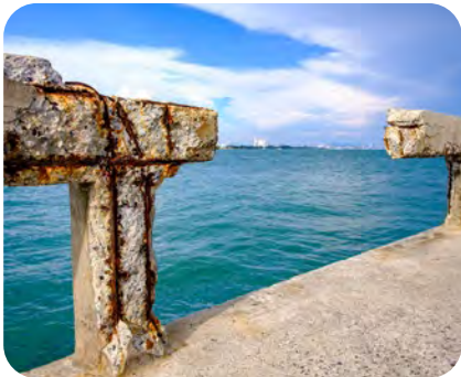
Salinité Corrosion, dissolution du ciment...
