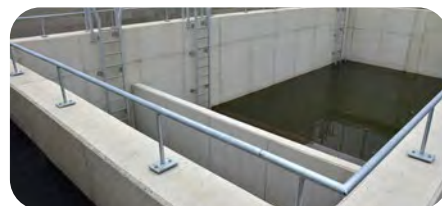
BASSIN DE RETENTION D'EAU USÉE
