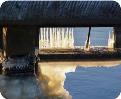
Cycles gel / dégel Variations de température autour du point de congélation, augmentation du volume massique du béton...
