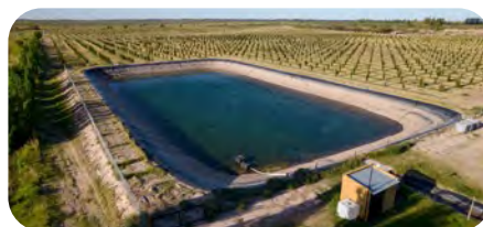
BASSIN DE RETENTION D'EAU PLUVIALE
