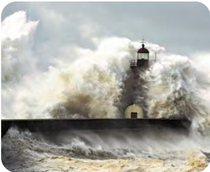
Altérations physiques Chocs de bateaux, Impacts, érosion, dommages liés aux événements climatiques extrêmes ou aux vagues.
