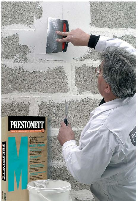
Bénéficiant d'une très bonne glisse, le nouveau Prestonett® M de Beissier s'applique facilement et rapidement sur des fonds sains, secs et propres, garantissant un rebouchage et un lissage optimaux des surfaces.
